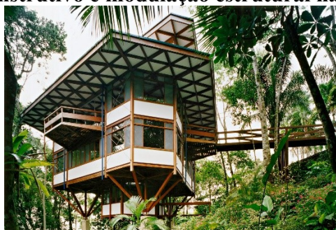
Figura 1: O detalhe construtivo e modulação estrutural na Residência Tijucopava
