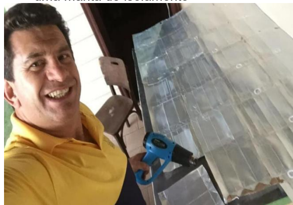
Figura 02: Unindo as caixas para formar uma manta de isolamento
