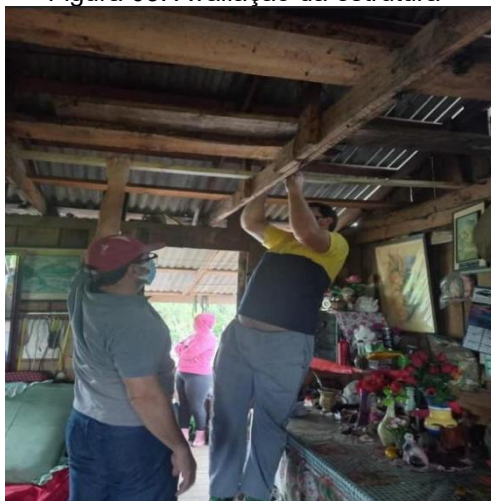
Figura 03: Avaliação da estrutura
