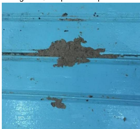
Figura 15: Reparos nas paredes
