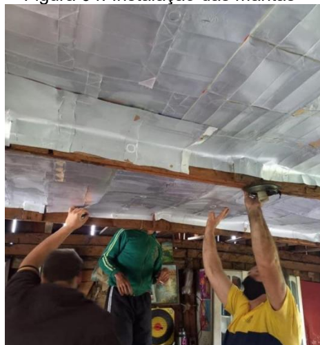
Figura 04: Instalação das mantas
